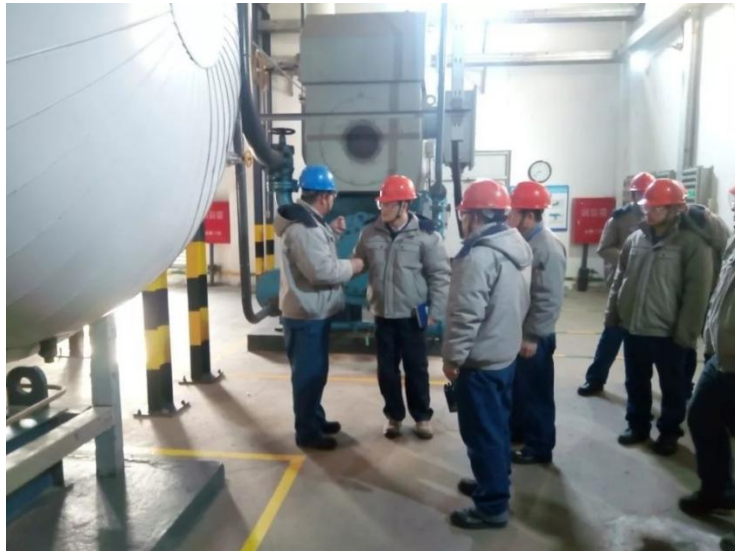
公司定期组织开展安全检查
