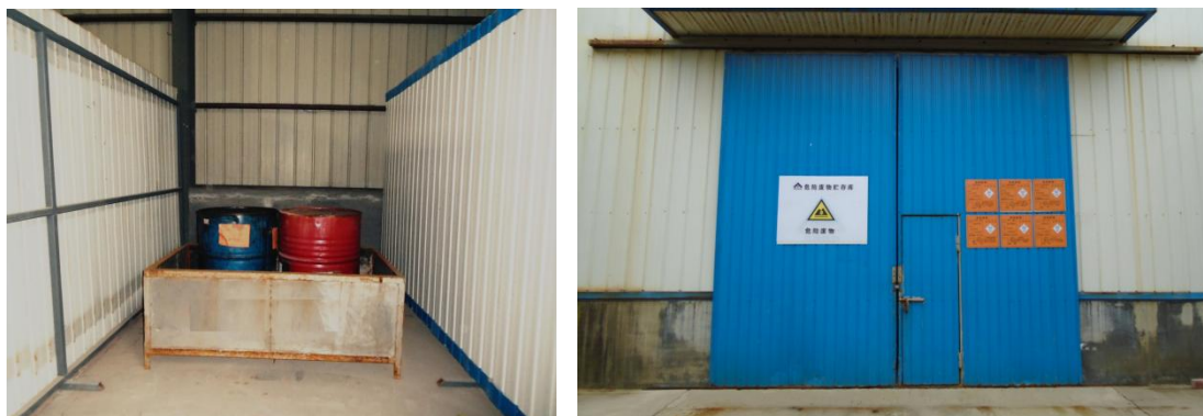
危险废弃物安全存放
