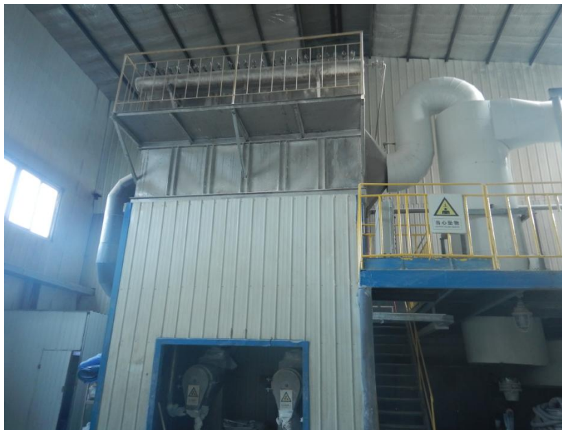
公司配置的布袋除尘器，除尘稳定、除尘效率高
