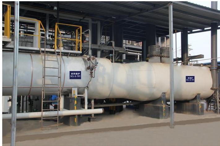
尾气焚烧炉：MVR车间系统工艺尾气经过液封罐、气液分离罐后通过尾气风机吹入焚烧炉内进行焚烧处理。通过炉前的风机将工艺尾气吹入焚烧炉，在850-950℃的条件下进行焚烧处理，焚烧后的高温烟气最后经过余热回收装置回收后，达标排放。（经第三方检测，焚烧处理后的烟气VOCs稳定在10mg/m<sup>3</sup>以下）。
