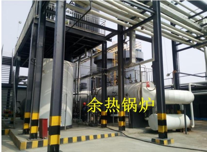
公司新增一台2 t 余热锅炉，将尾气焚烧项目直燃炉800℃左右的尾气，回收利用。高温尾气进入余热锅炉，排烟温度低于200℃，将蒸汽凝水转化成12 kg的蒸汽，产气量2.2 t/h。
