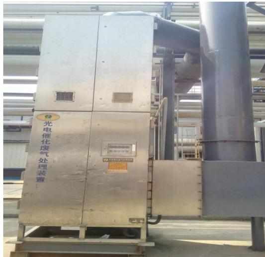
光电废气处理装置：为将生产过程中产生的挥发性有机物及异味污染环境，安装光电废气处理装置，光电废气处理装置能高效去除挥发性有机物（VOC）、无机物、氨气等主要污染物，以及各种恶臭味，脱除效率最高可达99%以上，尾气处理分析机理：短波紫外光的高能量可以使尾气物质的C-C、C-N、C-H、N-H、C-O、O-H等键断裂，然后在强氧化剂OH、O<sub>3</sub>等的作用下氧化为CO<sub>2</sub>、H<sub>2</sub>O等无毒无味物质。
