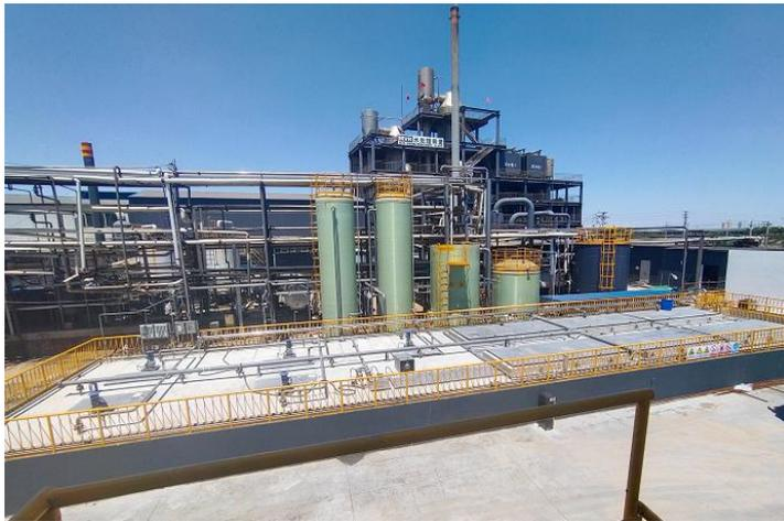
生化废水处理：为进一步稳定外排水质量，公司在MVR蒸发凝水深度处理的基础上，投资近1000万元上马一套A/O生化处理系统，用以进一步提升MVR凝水的处理效果。经过生化处理后出水COD $\leq$ 200mg/L，远低于排放指标。该技术的实施既提高了外排水的水质，使生产装置的环保性进一步提高，同时回用水质量的提升也进一步稳定了车间生产，降低了原材料消耗，真正意义上实现了“向环保技术要效益”的目标。
